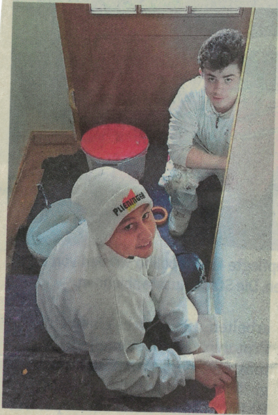
Jugendliche beim Renovieren des Treppenhauses der Südstadtkids. Foto: privat
